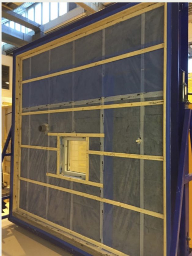
Lufttäthetsystem färdigt för provning.
